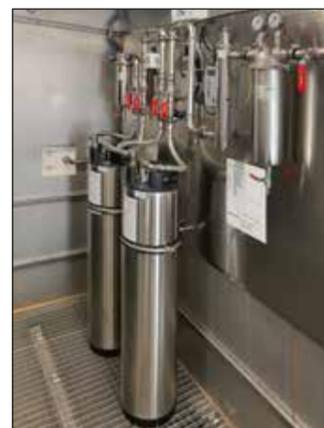
Abb. 2: Im MoHyPer integrierte Reinstwasseranlage
